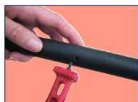
Perçage du PE (espacement 1 m - 1,50 m)
